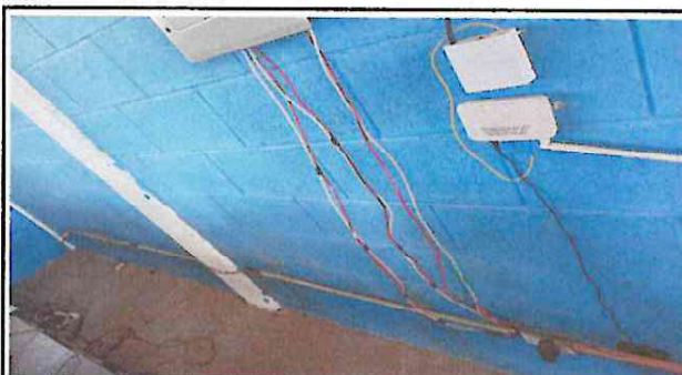
FOTO 6: Sustrucción de toma corrientes dobles Reparación de cableado eléctrico
