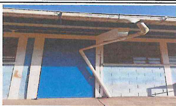
Foto 2: Reparación de bajadas de agua pluvial, tubo pvc 3"
