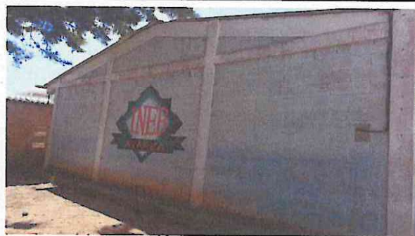
Foto 8: Pintura en muros exteriores e interiores
