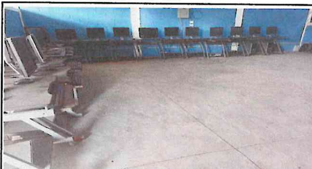
FOTO 10: Sustitución de piso de torta de concreto, a piso cerámico
