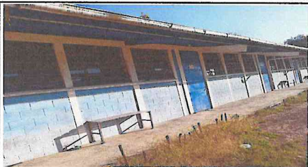
Foto 1: Sustrucción de canal de pvc
