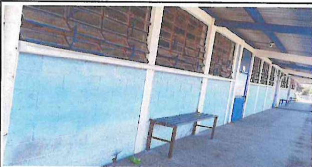
Foto 9: Pintura en paredes exteriores e interiores
