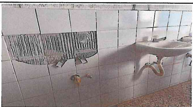
Foto 3: Sustrucción de lavamanos Sustrucción de mezcladora lavamanos (contra llave, tubo de abasto)
