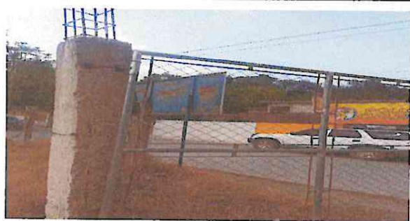
Foto 11. Pintura y reparación a porton principal
