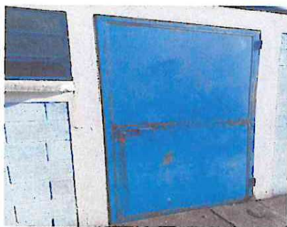
Foto 7: Mantenimiento a estructura de puertas de metal (lijado, cepillado, aplicación de pintura)
